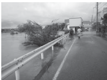
同地区の浸水被害の様子
