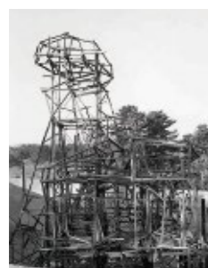
1980年 サル山築造工事
