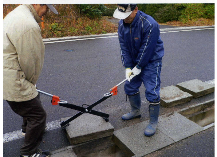
【作業状況～側溝蓋揚げ機】
