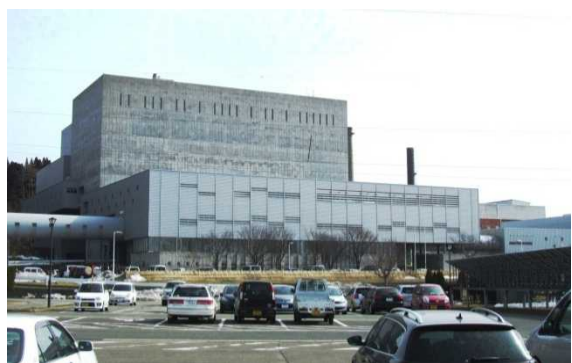
総合環境センター溶融施設 (平成14年完成)
