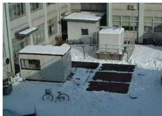
左：山王中学校の地中熱利用システム（三菱マテリアルテクノ資料） 右：秋田大学校内融雪実証施設（秋田大学資料）
