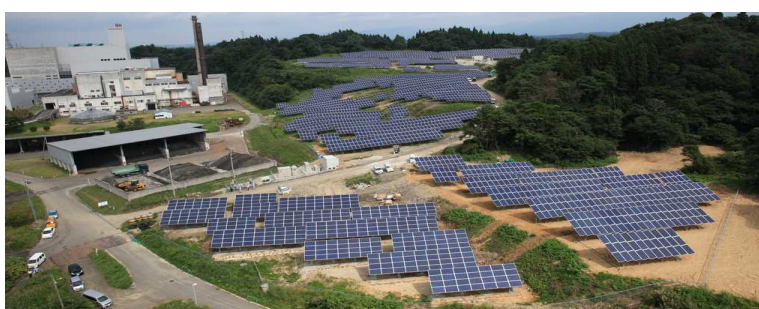
秋田市メガソーラー発電所
