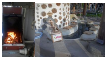
薪ボイラーを 利用した足湯
