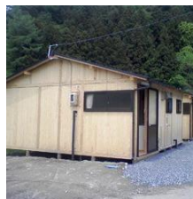
地域の材の 仮設住宅
