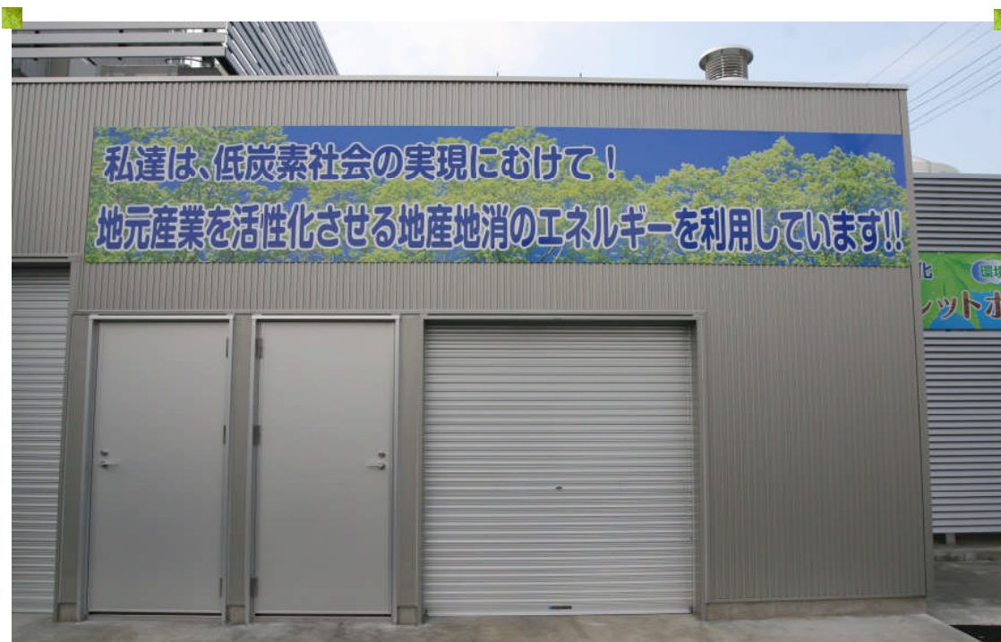
ペレットボイラー設備を格納する建屋正面
