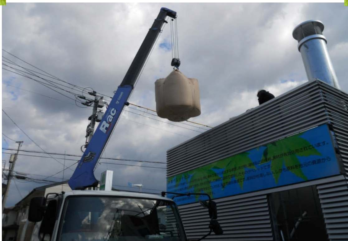
燃料タンクにペレットを搬入しているところ
