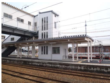
こ線橋の改築とともに、新たに設置されたエレベーター(上りホーム側)
