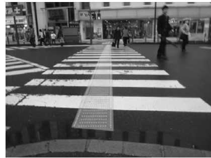
エスコートゾーンの設置
