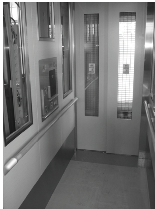
エレベーター室内
