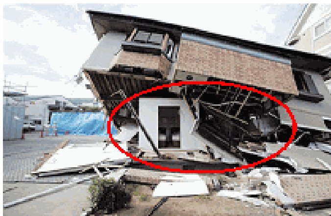
鍵屋一氏「災害時の高齢者、障がい者の支援」耐震木質シェルターより (秋田市主催「積雪期の地震対策シンポジウム」の講演にて)
