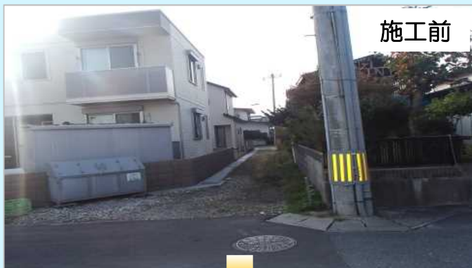
▶ 道路を拡幅しました (区画道路6-67号線/幅員6m)
