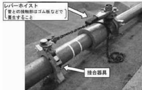
図-3.22 GX形用の器具を用いた接合例1 図-3.23 GX形用の器具を用いた接合例2
