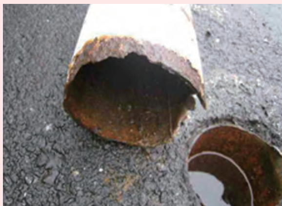
ポールの根腐れによる倒壊
