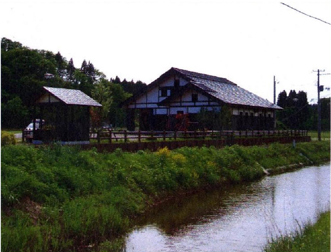
上北手東部農業集落排水処理施設
