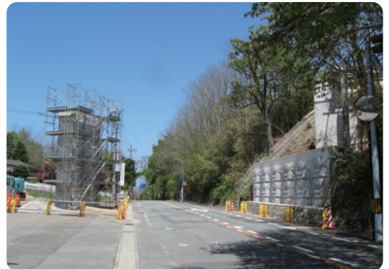
道路が開削された場所に史跡公園連絡橋を整備中
