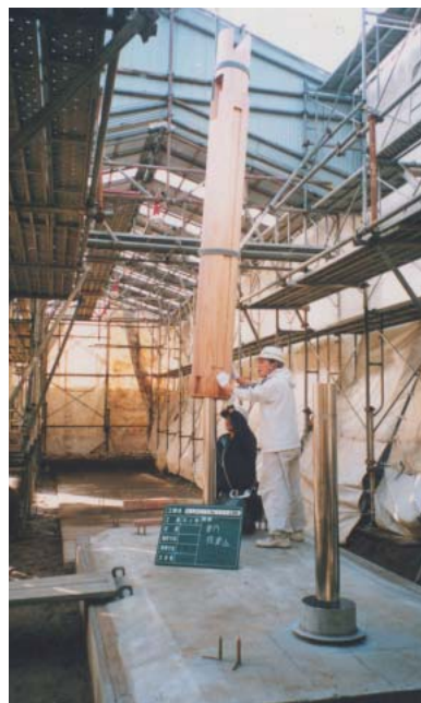
■政庁東門柱設置状況
