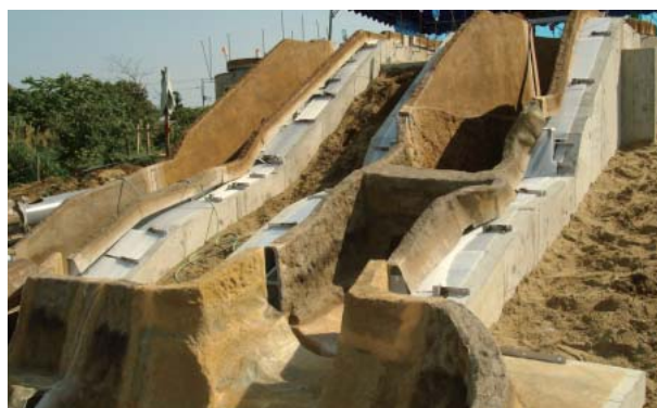
■木樋等複製品設置状況
