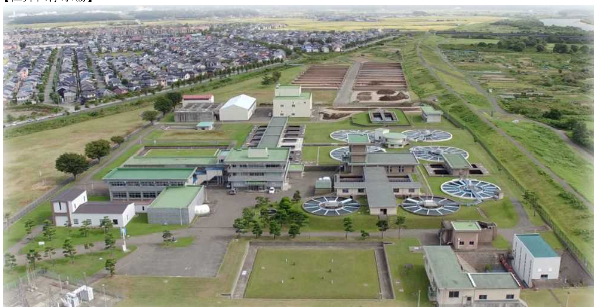
【仁井田浄水場】
