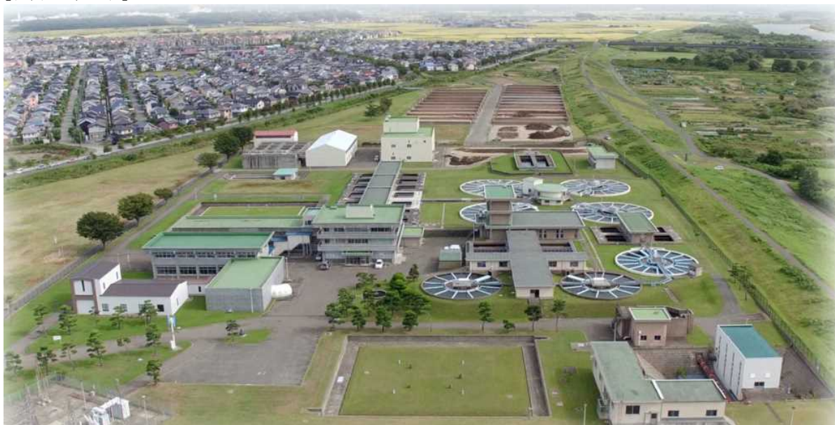
【仁井田浄水場】
