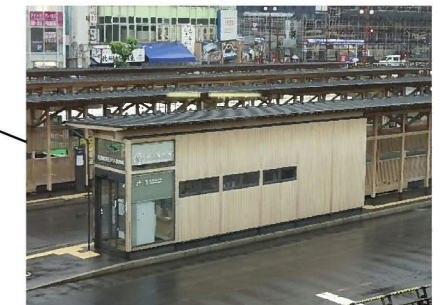
駅西口バスターミナル改修
