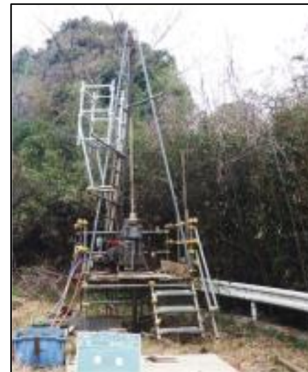
ボーリング仮設例
