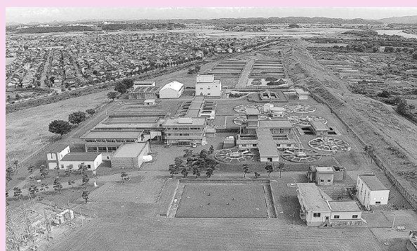
仁井田浄水場の全景。稼働開始は昭和32年で、現在、中央・東部・南部・北部・雄和の各地域に供給を続けています
