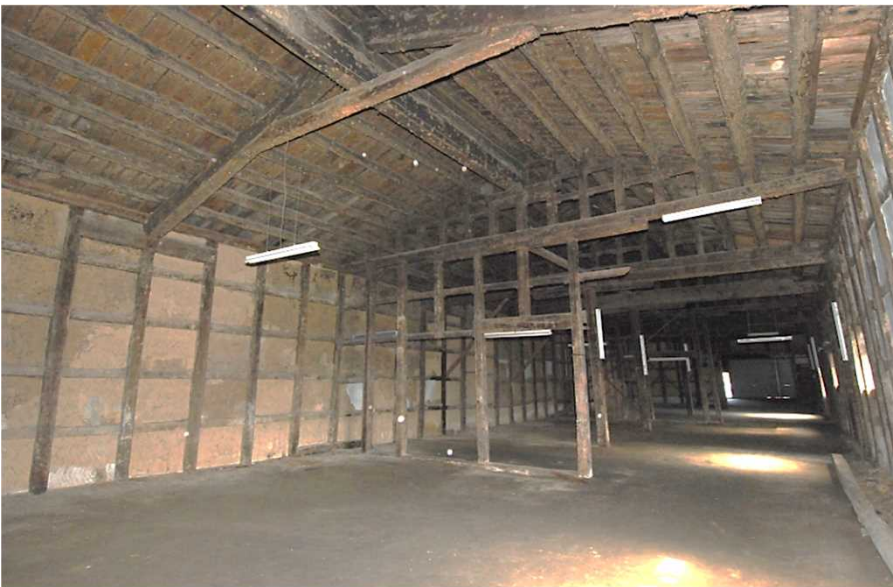
写真8 主体部北桁行 内側壁
