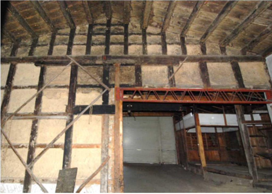
写真6 主体部東梁間 内側壁
