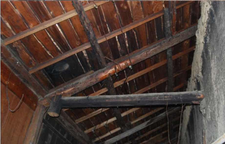
写真11 垂木と貫の連結部
