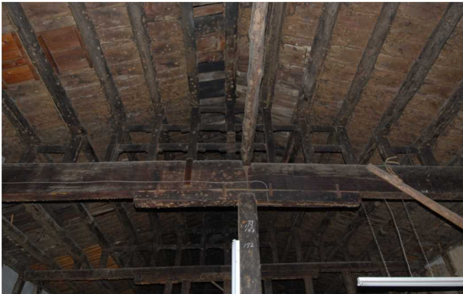
写真19 8柱間目梁小屋組 東から
