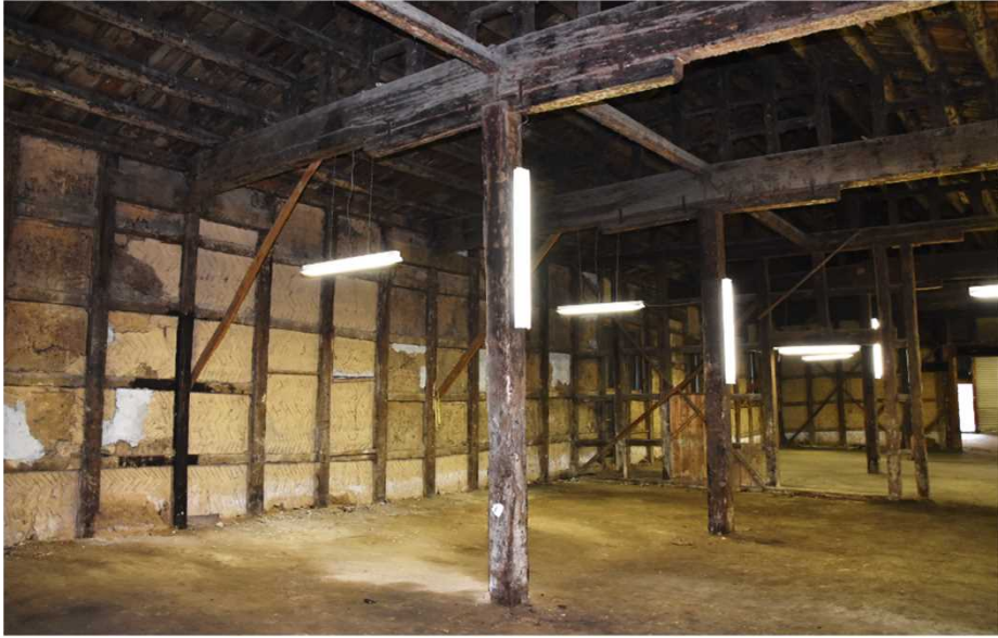
写真24 16柱間目の梁と20柱 間目の梁の梁がかり 西から
