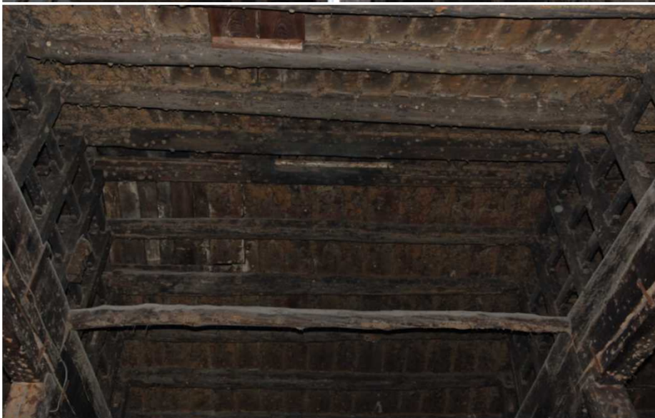
写真20 4柱間目梁と8柱間 目梁の梁かかり
