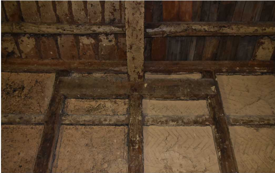
写真18 梁と桁柱の肘木
