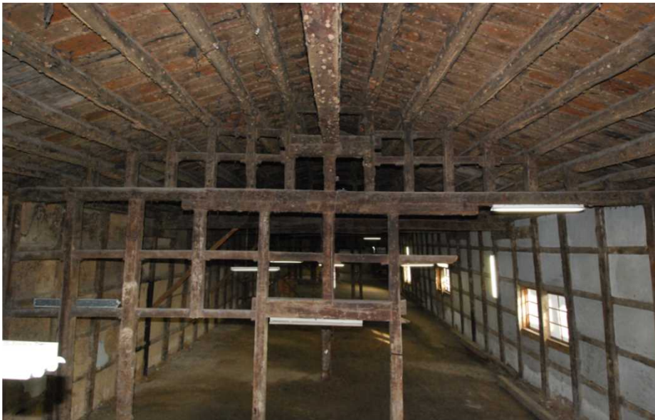
写真25 24柱間目の梁 西から
