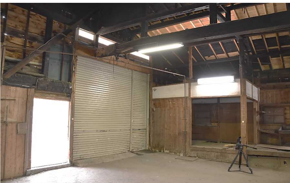
写真5 倉前内部東梁間
