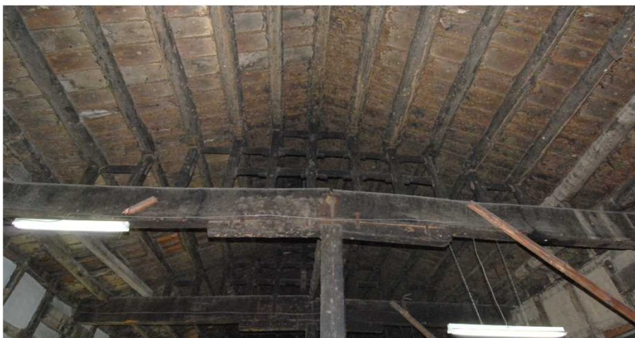
写真17 4柱間目梁小屋組 東から
