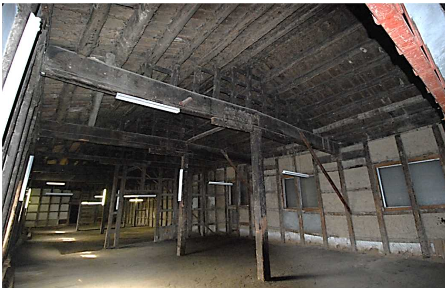
写真16 手前4柱間目梁 東から
