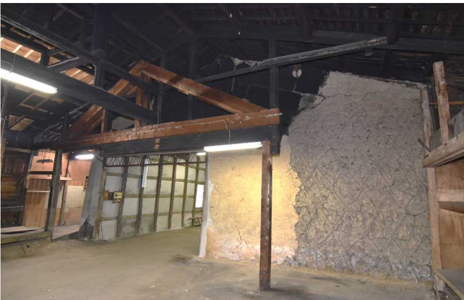
写真4 倉前内部西梁間
