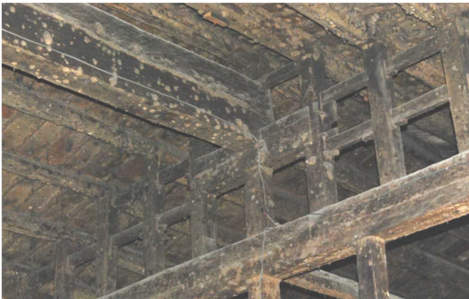
写真26 24柱間目の梁の 小屋組 西から
