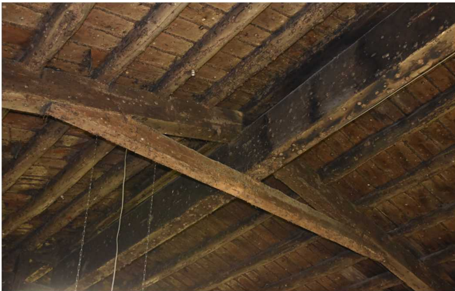
写真28 28柱間目の垂木と 帯梁
