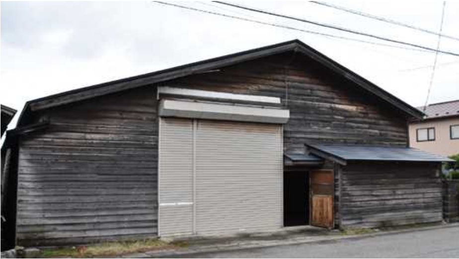
写真3 倉前外観 東から
