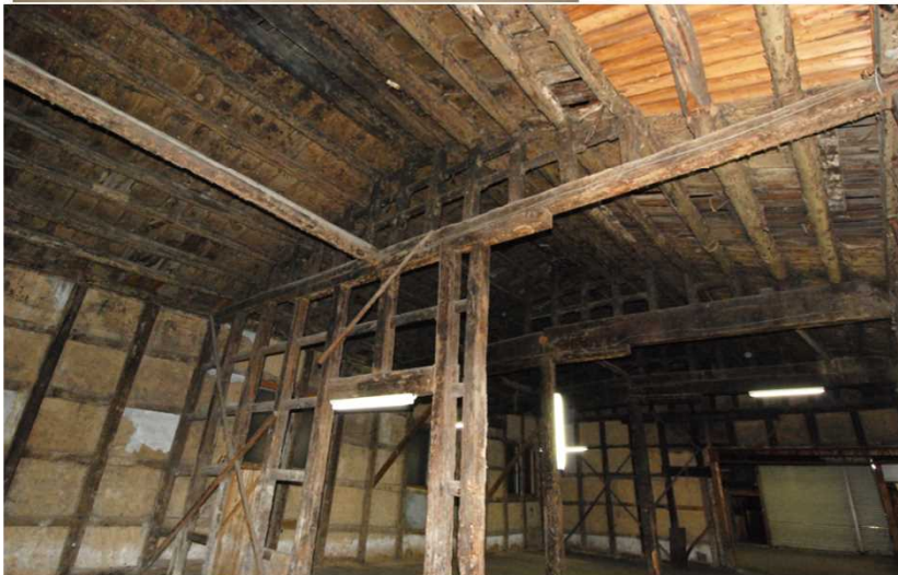
写真22 12柱間目の梁から16柱間目 の梁への梁がかり
