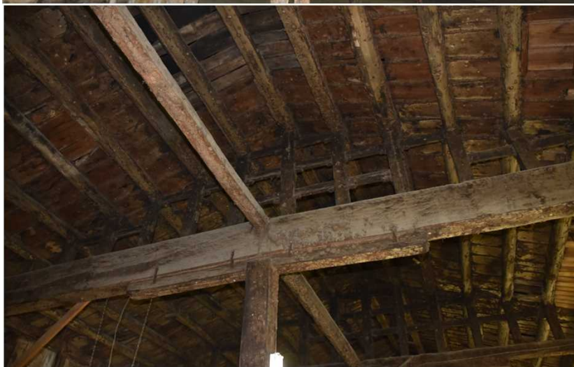
写真23 16柱間目の梁 西から
