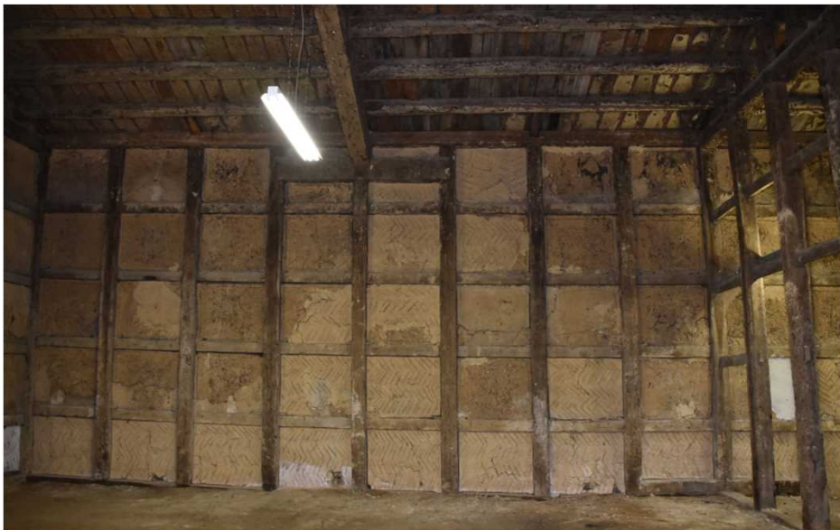
写真13 主体部北桁行側 内壁
