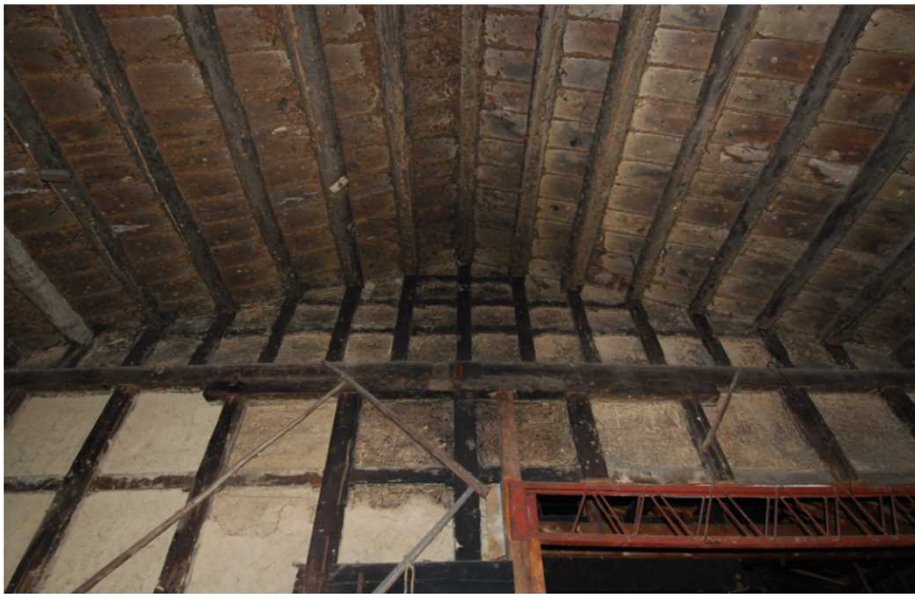
写真15 東梁間小屋組
