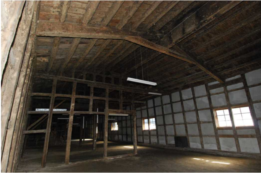
写真27 24柱間目の梁から28 柱間目の梁の垂木、 帯梁
