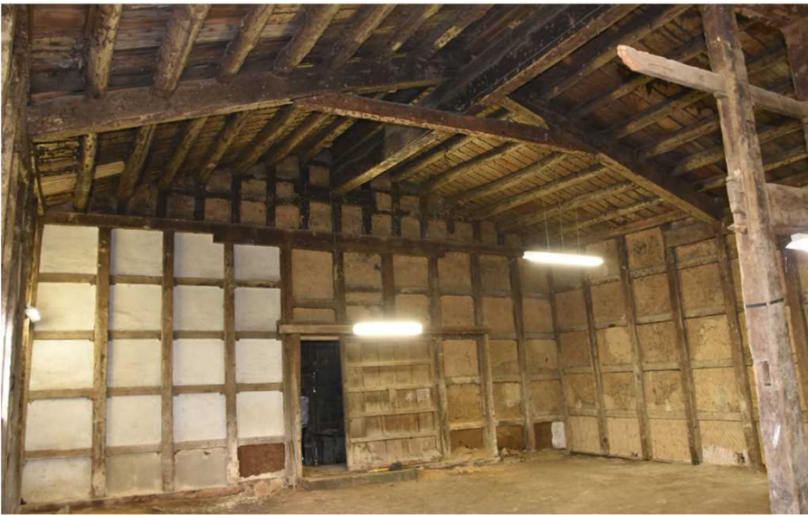
写真7 主体部西梁間 内側壁
