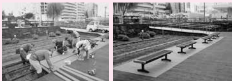
作業の様子。右が完成後のウッドデッキ
