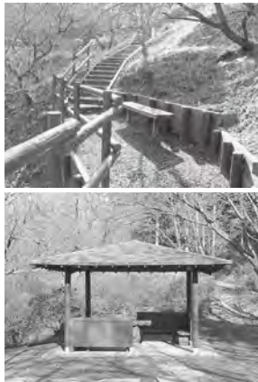
改修した園路(上)と東屋(下)
