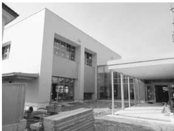
建設中の仁井田コミセン
