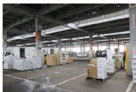
大屋根がかかった作業場（札幌市場）
