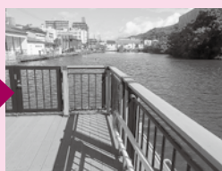
完成した手すり
