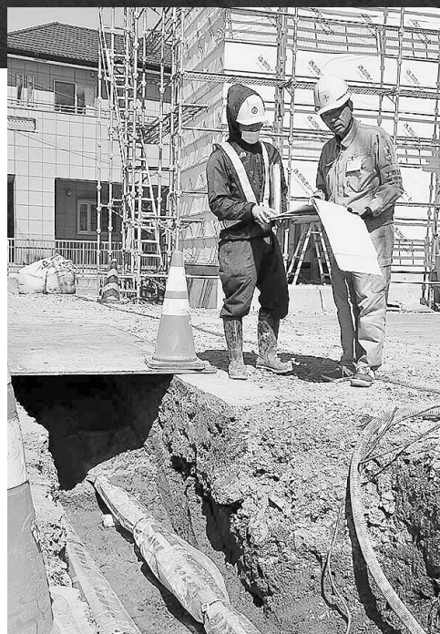
現場で作業工程を確認する松本さん(右)
