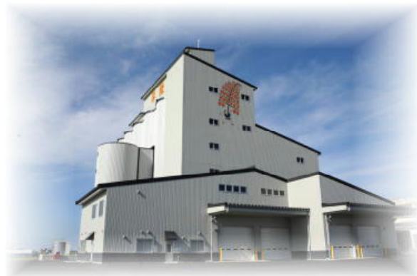
大規模乾燥調製貯蔵施設
