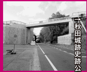
来春完成予定の連絡橋
