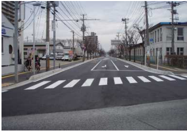
川尻広面線 歩道改良
