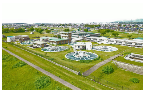
仁井田浄水場
