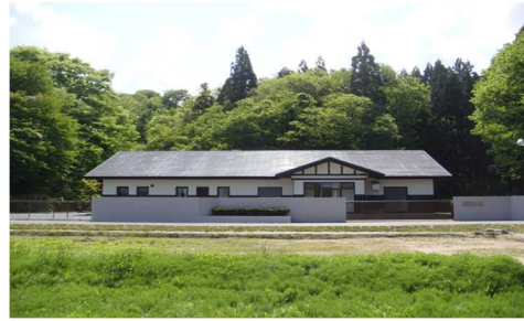
下北手中央農業集落排水施設
