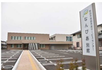
南部市民サービスセンター別館
