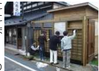
空き地の景観整備実験(屋台塀)
