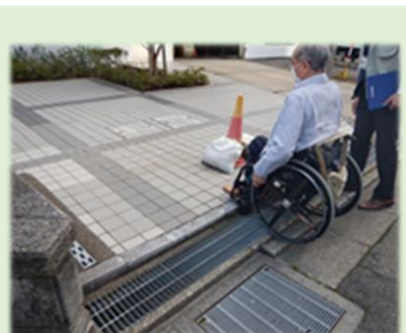
(歩道と駐車場敷地との段差)
