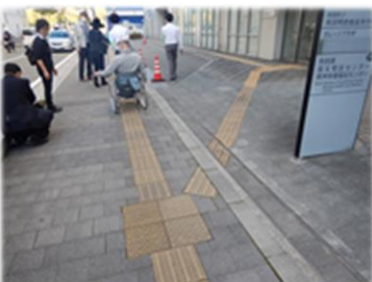
(建物まで連続した点字ブロック)
