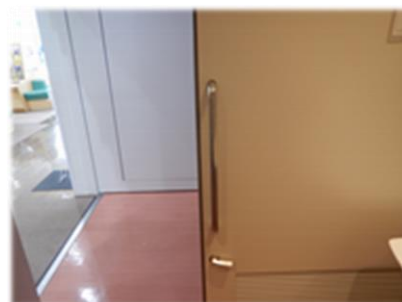
(鍵が手すりの下のみの扉)
