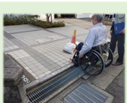
(歩道と駐車場敷地との段差)
