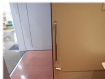
(鍵が手すりの下のみの扉)
