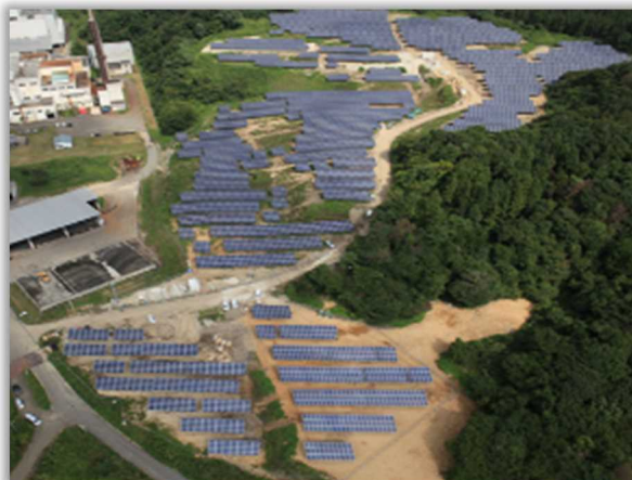
秋田市メガソーラー発電所
