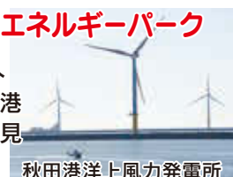
秋田港洋上風力発電所
