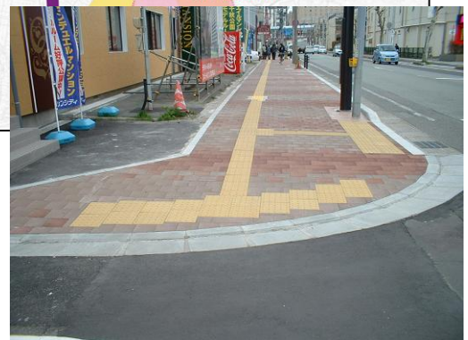
▲バリアフリー化された歩道
