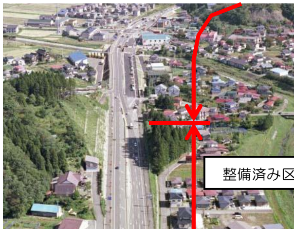
▲ 21 一般国道13号河辺拡幅
