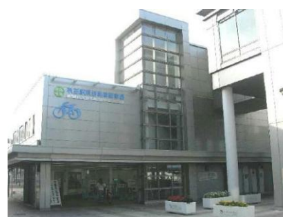
▲秋田駅東自転車等駐車場
