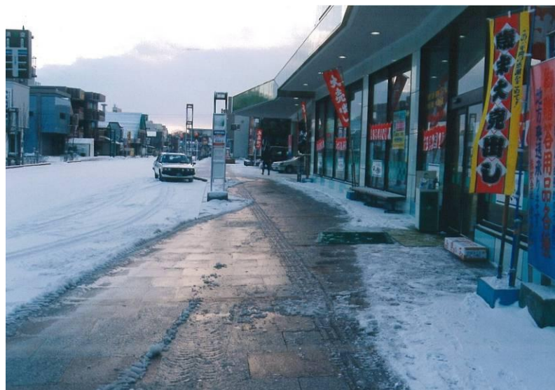
▲歩道消融雪の稼働状況
