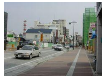
▲無電柱化された歩道
