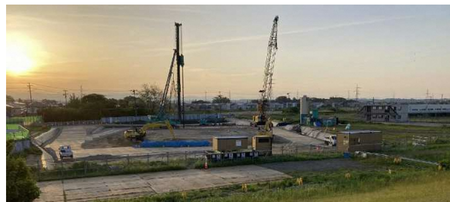
ポンプ場全景（杭打工事準備状）
