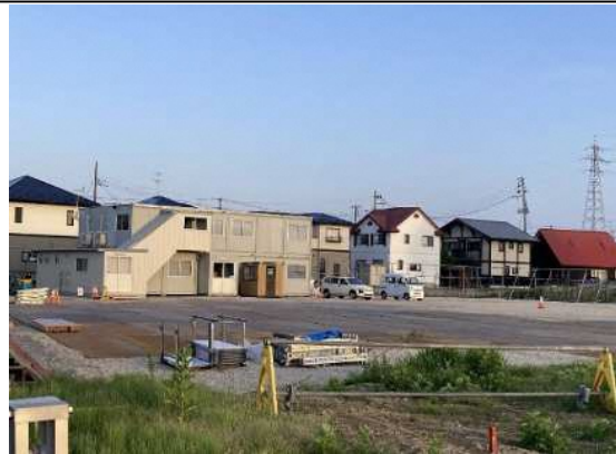
現場事務所設置
