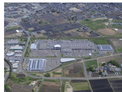
盛岡市中央卸売市場のメガソーラー 最大出力 1,580 キロワット (盛岡市環境部 HP より)
