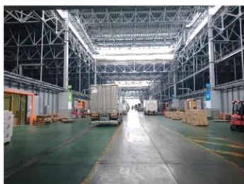
卸売場西棟の入荷用通路
