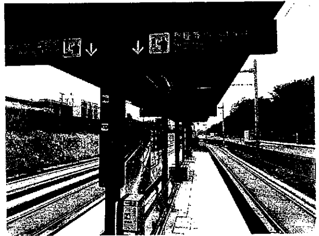
ライトライン (LRT) の駅の様子。駅の設置が非常に簡単にできる。
