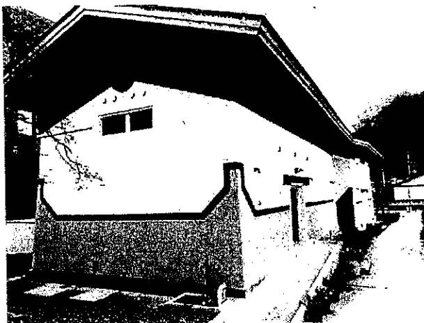
子どもの森遠野を建設する際に併せてリノベーションした敷地内の蔵。会議や演奏会に利用されている。
