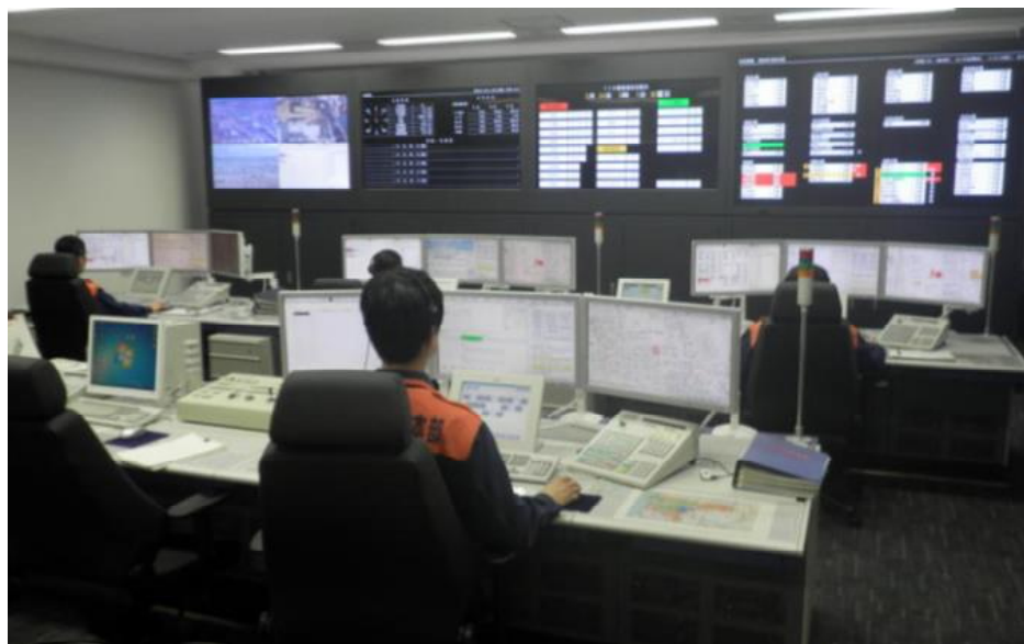
消防指令センター
