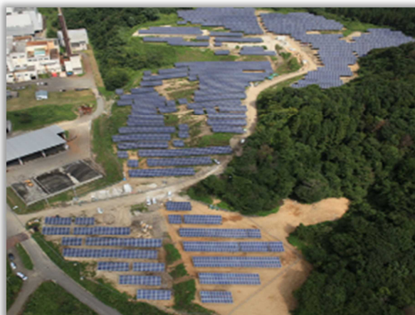
秋田市メガソーラー発電所
