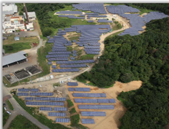
秋田市メガソーラー発電所
