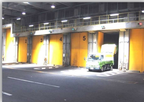
秋田市総合環境センター （ごみを受け入れるプラットフォーム）
