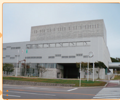
溶ゆう施設(ごみを溶かす施設)
