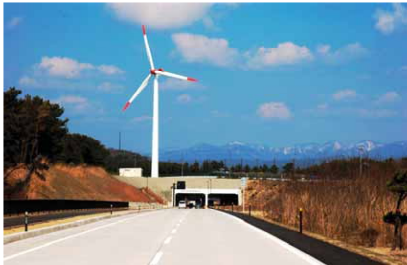
秋田南バイパス風力発電設備 (国土交通省東北地方整備局秋田河川国道事務所)
