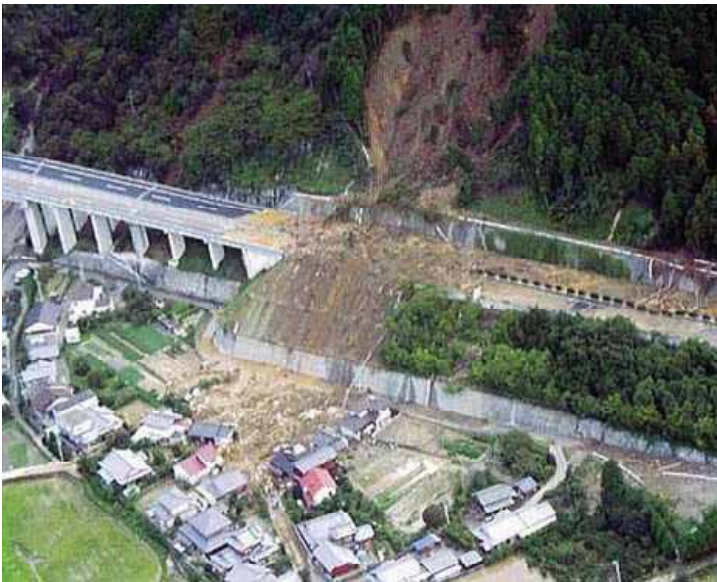
出典) 国土交通省 (愛媛県新居浜市大生院で発生した土砂災害)
