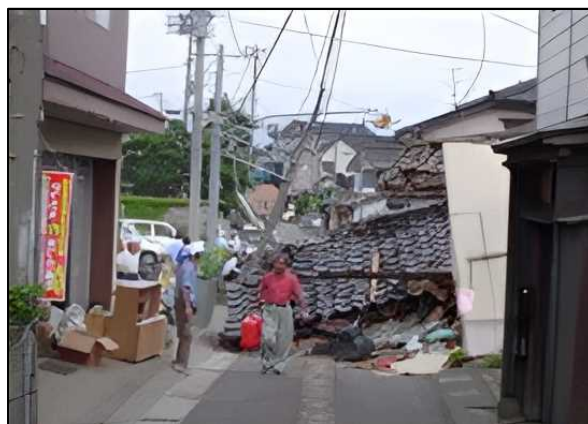
写真1-1 道路閉塞状況
