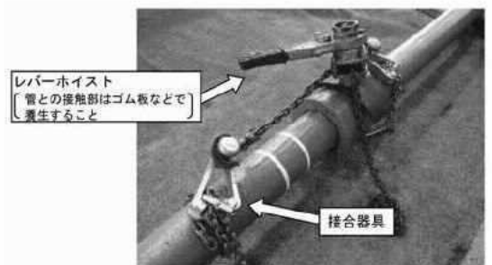
図-3.22 GX 形用の器具を用いた接合例 1 図-3.23 GX 形用の器具を用いた接合例 2
