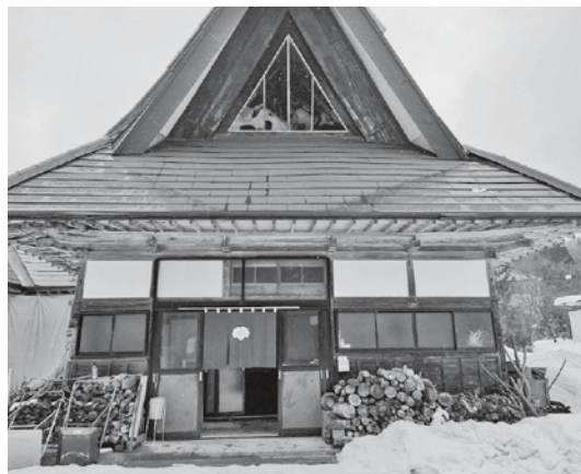
築200年を超える立派な古民家
