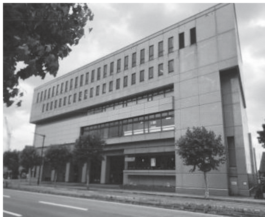
いざ解体となると寂しい思いがこみ上げてくる
